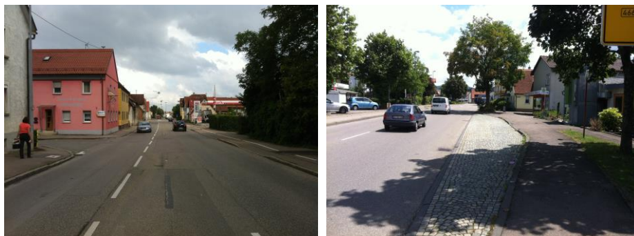
Abbildung 26: Überbreite Fahrbahnen in der Hauptstraße (links) und in der westlichen Donzdorfer Straße (rechts)
